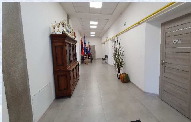
Pohľad na vstupnú chodbu po úpravách
